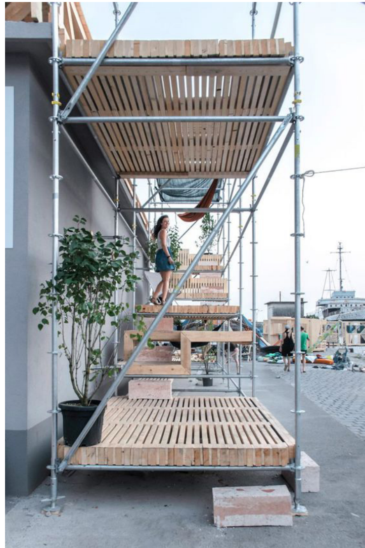
Brug af genanvendte materialer til terrasseopbygning
