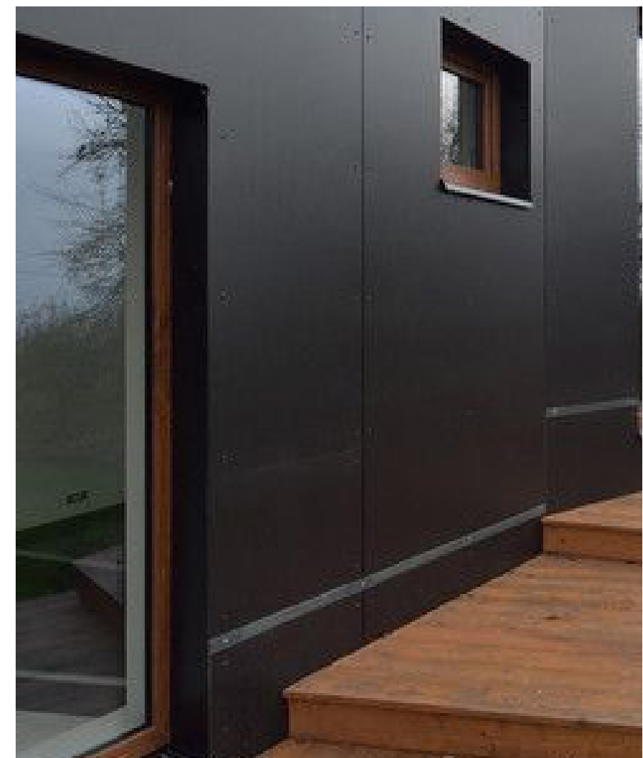
Sorte Rockpanel-plader til brug i facadebeklædning på fælleshus
